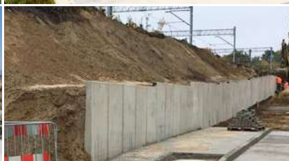
budowa modułowa zabezpieczenie zboczy i nasypów
